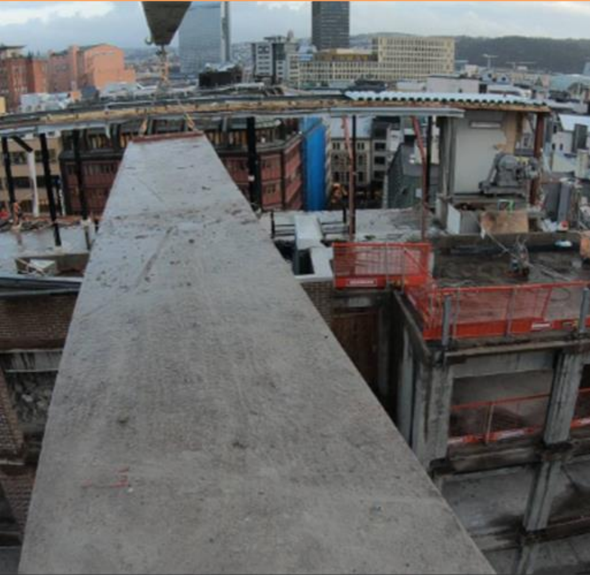
2019 KA13 (Entra, Mad arkitekter) Ombruk av hulldekker fra regjeringkvartalet
