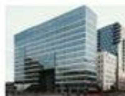
10 Dronning Eufemiasgate 8 (Braathen eiendom) Komfortkjøling Rekkverk Belysning Glassfasader Gulvoverflate Sanitær Brannslange- skap Innvendig kledning Inneder
