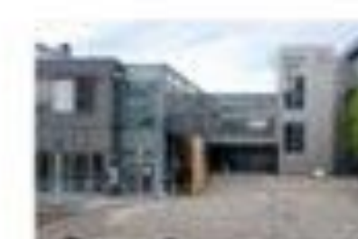
17 Refstad skole (Under- visningsbygg - UBF) Himling Skap og reoler Dørvidder og dørpumpe Sanitær Kledning Elektrisk Toaletter Radiatorer
