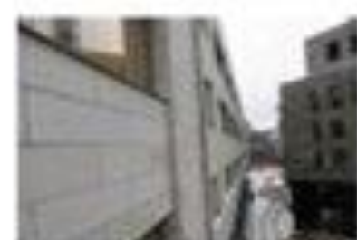
14 Drammensvn. 134 (Entra) Stein fasadeplater
