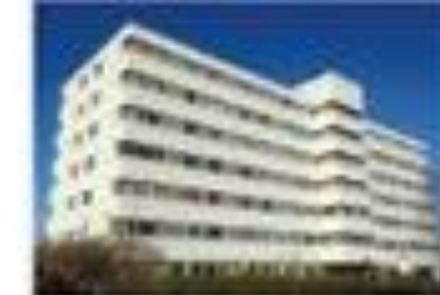
5 Oppsalhjemmet (Omsorgsbygg - OB) Utvendig kledning og overflate
