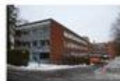
16 Lambertseter Sykehjem (Omsorgsbygg - OBY) Kjøkkeninnredning Servantbatterier Kjøkkenarmatur
